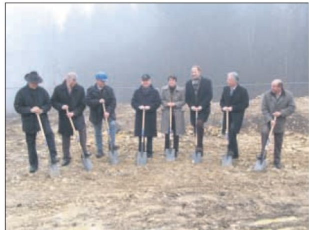
Beim Spatenstich von rechts: Günter Lumppp vom Regierungspräsidium, Dr. Eduard Leiber vom Ingenieurbüro Fritz, Bürgermeister Dr. Daniel Rapp, Umweltministerin Tanja Gönner, Landtagsabgeordneter Ernst Behringer, Ernst Berger von der Baufirma Berger, Bernd Aßfalg, Leiter der Stadtwerke Sigmaringen, und Christian Berger von der Baufirma Berger
